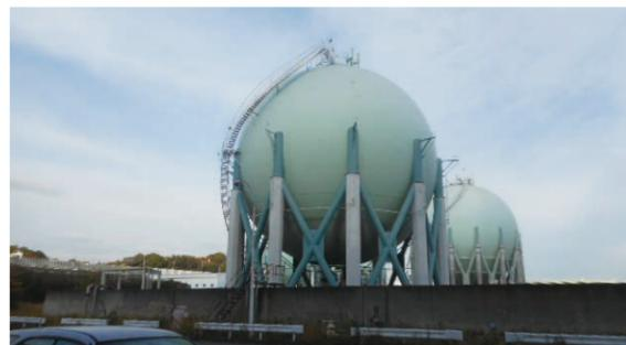
球形タンクのブレース(筋交い)補強
