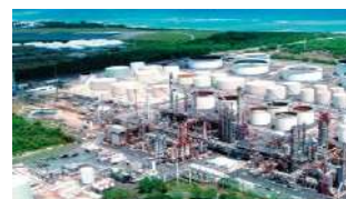
Kapolei Refinery, Par Pacific Holdings, Inc.
