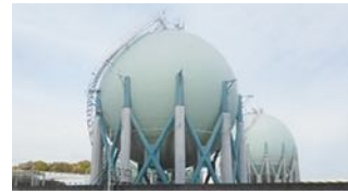
球形タンクのブレース（筋交い）補強
