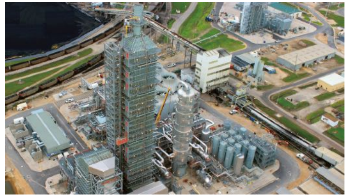
CO 2 回収プラント (米国テキサス州)
