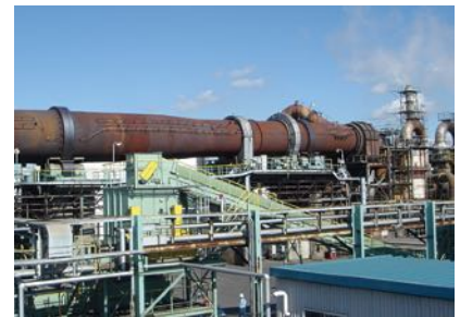
JX金属苫小牧ケミカル ロータリーキルン式焼却炉
