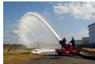
大容量泡放水砲（大分製油所）
