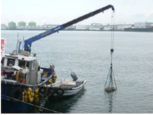
藻類等が着生しやすいブロックの設置
