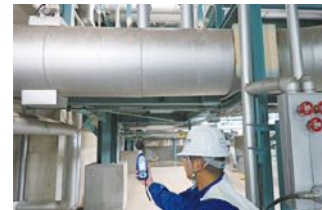
騒音測定の様子
