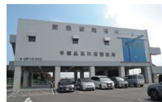
高所保管倉庫（製油所）
