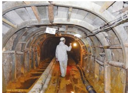
花輪鉱山 坑道点検の様子
