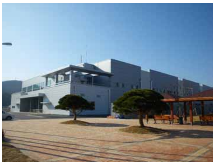
< PCT社の工場外観 >
