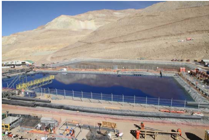
浸出液貯留池
