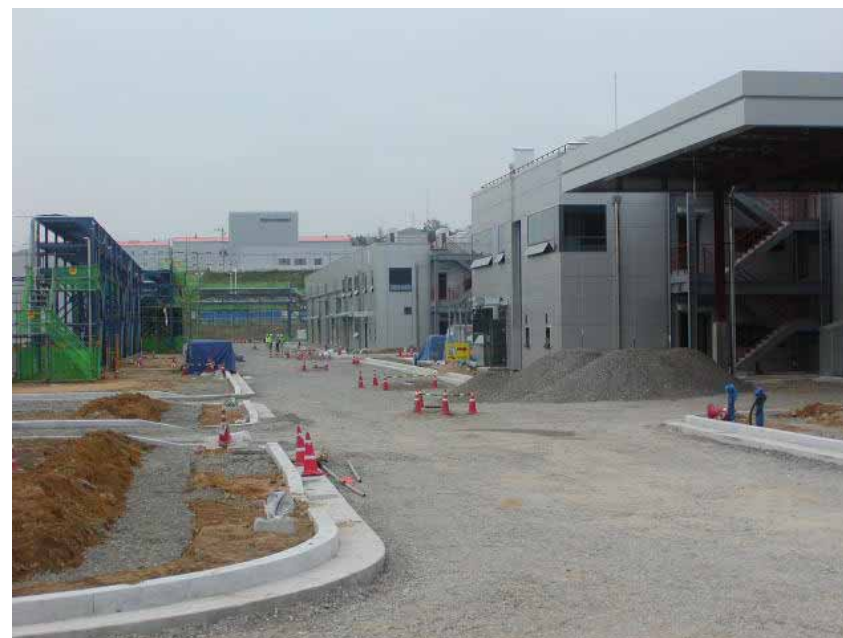
バッテリーセパレーターフィルム工場の建設 (韓国亀尾市)
