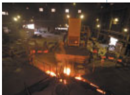
設備更新された佐賀製錬所のアノード鑄造機
