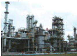
鹿島製油所のサルファーフリーガソリン製造設備
