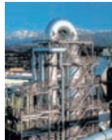
日鉱三日市リサイクル(株)のガス化溶融炉
