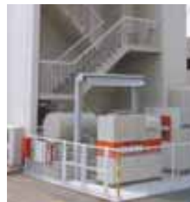
灯油を原燃料とする業務用10kW級燃料電池
