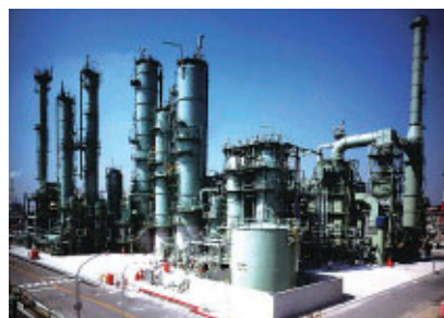
パラキシレン製造装置(堺工場)
