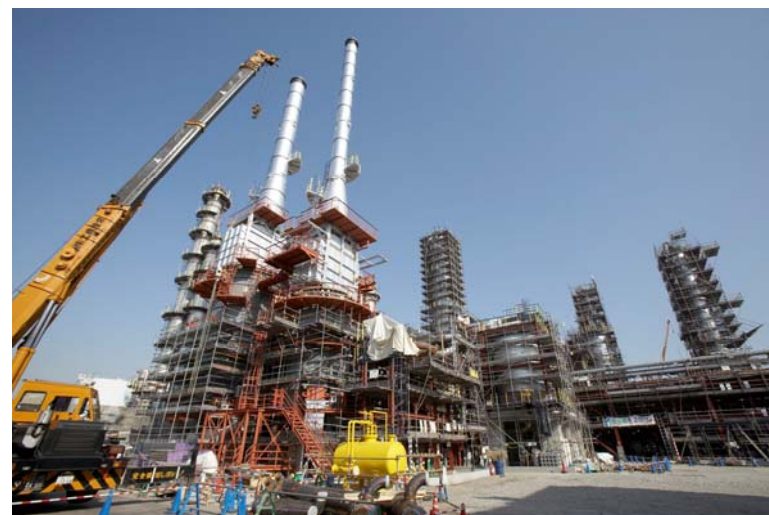
川崎工場に建設中の超低硫黄燃料油製造装置
