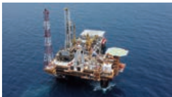
SK10鉱区の生産プラットフォーム
