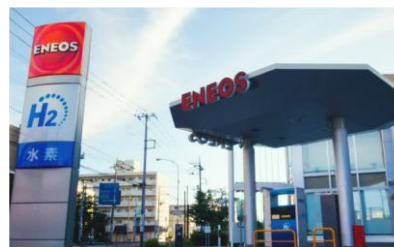
水素ステーション
