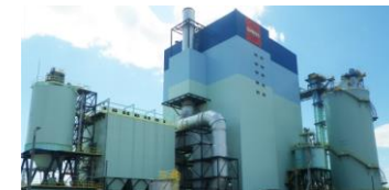
室蘭バイオマス発電所
