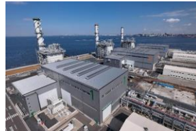
五井火力発電所
