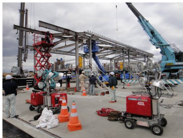
設置中の暫定出荷設備
