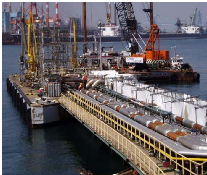
復旧作業中の出荷棧橋
