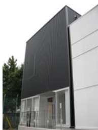
技術研究所遠心実験棟
