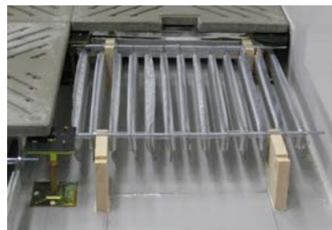
PCM 蓄熱材設置状況 (施工中)
