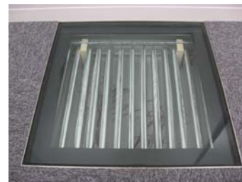
PCM 蓄熱材設置状況 (完成)
