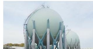
球形タンクのブレース（筋交い）補強
