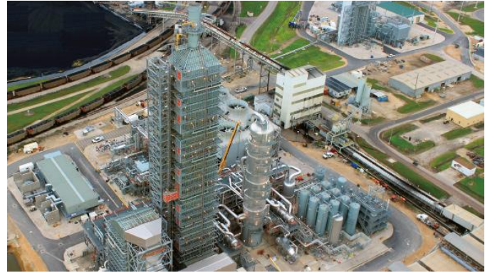
CO 2 回収プラント（米国テキサス州）
