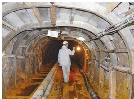
花輪鉱山 坑道点検の様子
