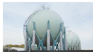
球形タンクのブレース（筋交い）補強
