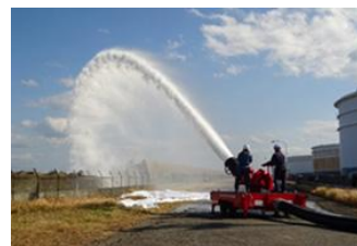
大容量泡放水砲（大分製油所）
