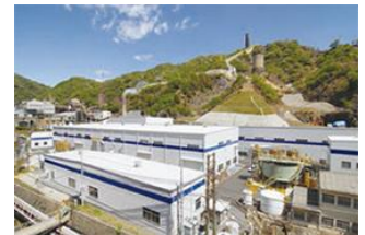
JX金属製錬 日立工場HMC製造部
