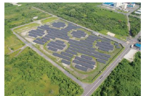
下松メガソーラー発電所
