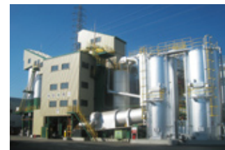
アスファルト舗装をリサイクルする (株)NIPPO京都合材工場
