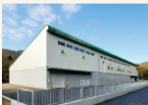
廃水処理設備外観
