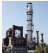
水島製油所の 常圧蒸留装置
