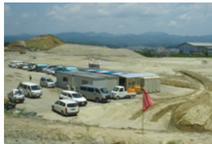
プレス・めっき加工を行う新工場建設予定地(静岡県掛川市)
