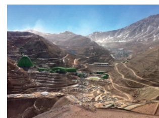
カセロネス銅鉱山全景
