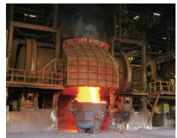
佐賀製錬所のリサイクル工程(転炉)
