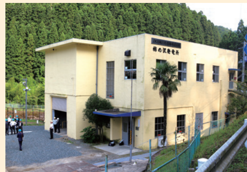
リニューアルした柿の沢発電所
