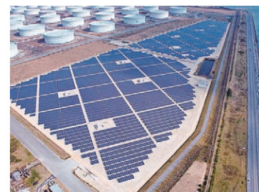
うるまメガソーラー発電所
