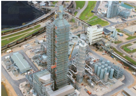
CO 2 回収プラント
