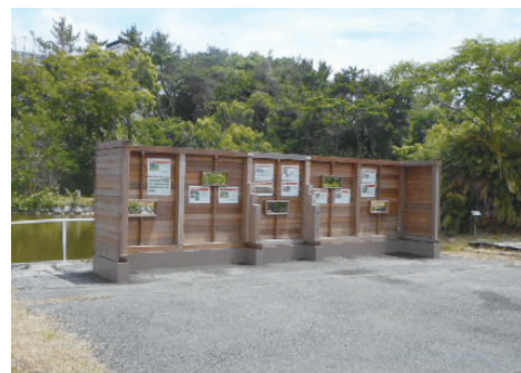
設置された野鳥観察舎
