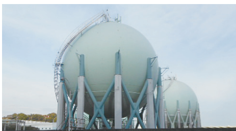
球形タンクのブレース(筋交い)補強
