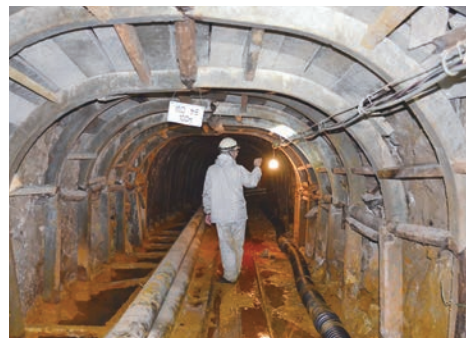
花輪鉱山 坑道点検の様子
