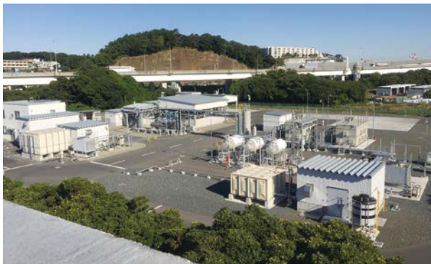
水素製造出荷センター（横浜市中区）
