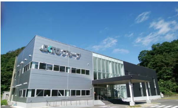
JXTGグループ危険体感教育センター
