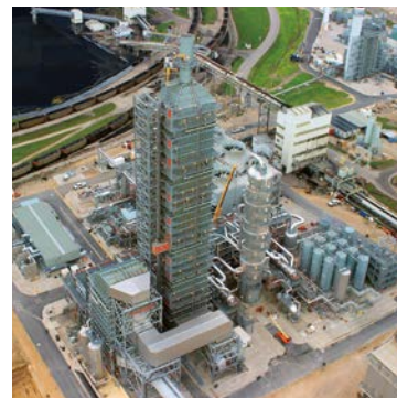
CO 2 回収プラント
