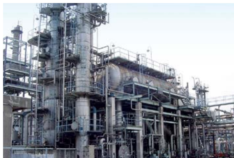
排煙脱硫装置
