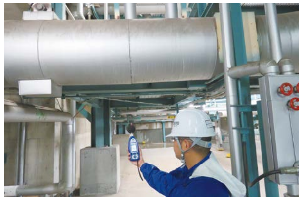
騒音測定の様子
