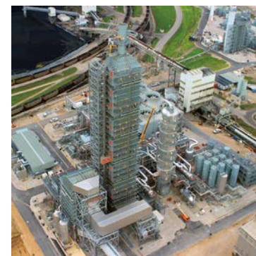
CO 2 回収プラント
