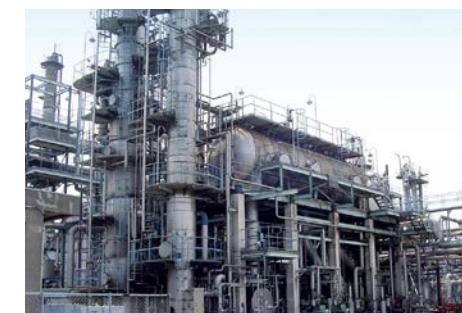
排煙脱硫装置
