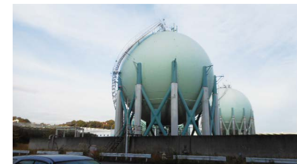
球形タンクのブレース(筋交い)補強
