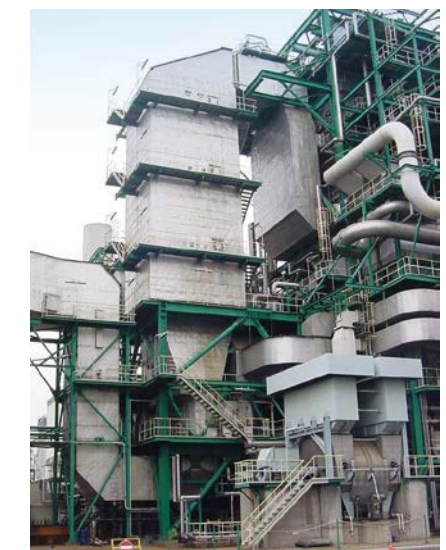
排煙脱硝装置
