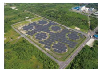
下松メガソーラー発電所
