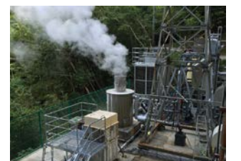
下田温泉バイナリー発電所
