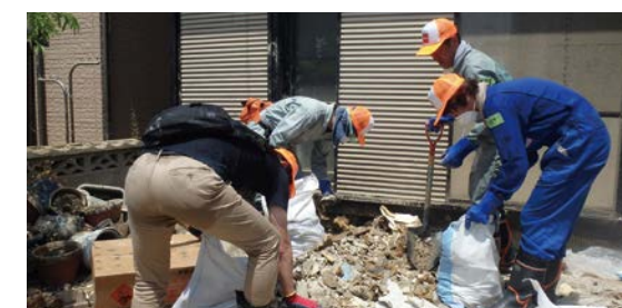
瓦礫撤去作業の様子
