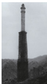
竣工直前の「大煙突」
