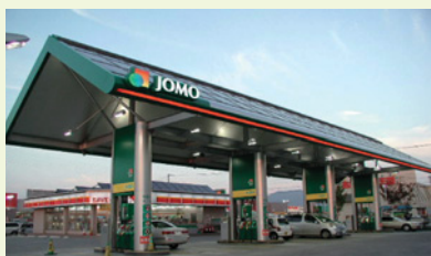
太陽光発電パネル設置JOMOステーション
