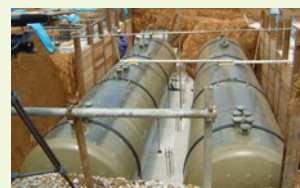
二重殻タンク更新工事
