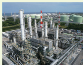
アロマ製品製造設備 (鹿島製油所)
