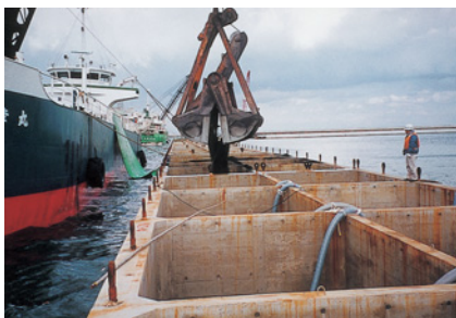
ケーソン*に充填中の銅スラッジ
