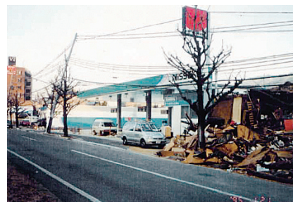
SSの安全性を実証した 阪神・淡路大震災直後(1995年1月)の様子 (写真提供: (株) タツノ・メカトロニクス)
