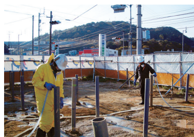
サービスステーション跡地における浄化工事
