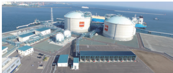
Hachinohe LNG Satellite Terminal
