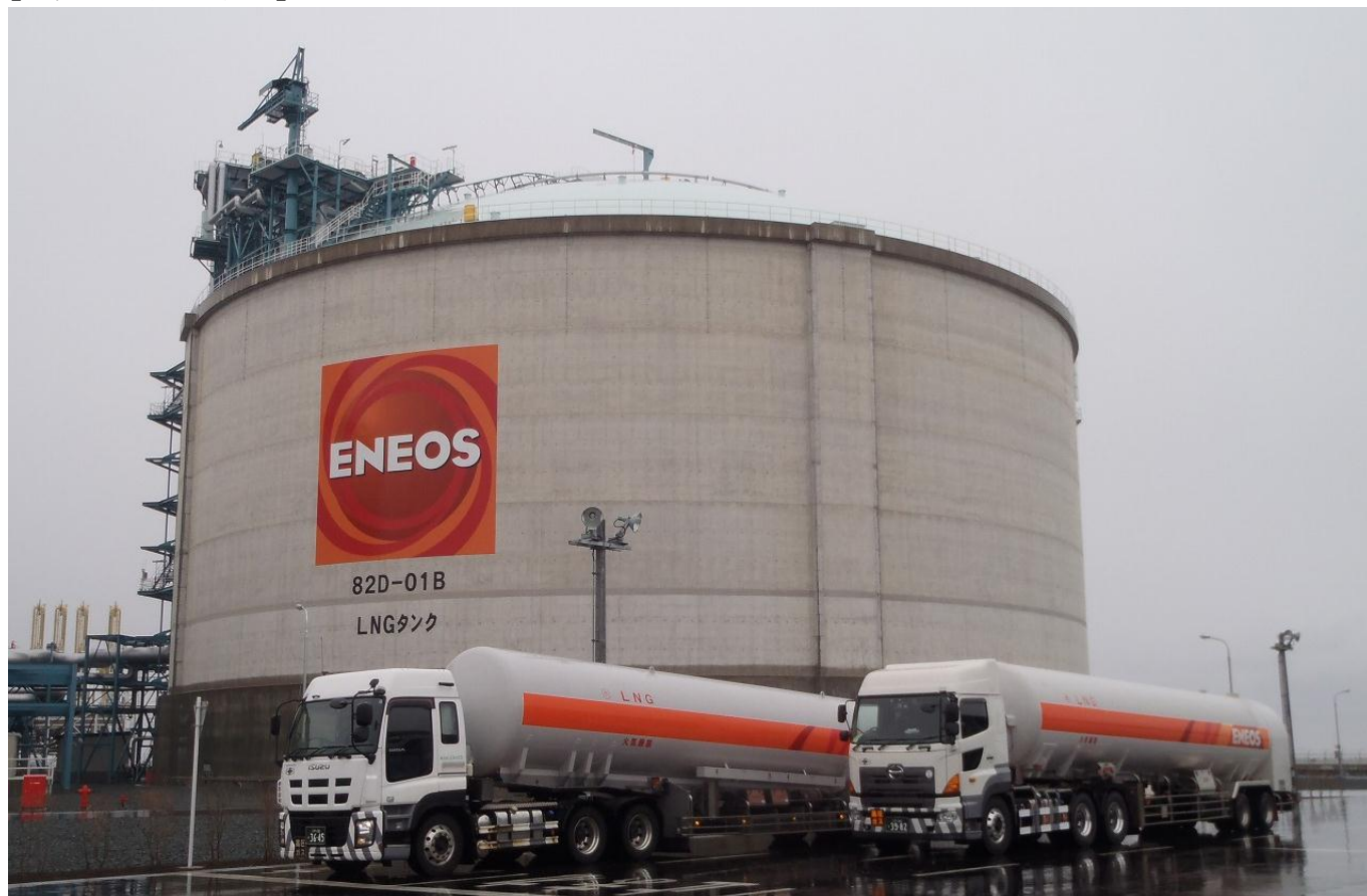
【八戸LNGターミナル】
