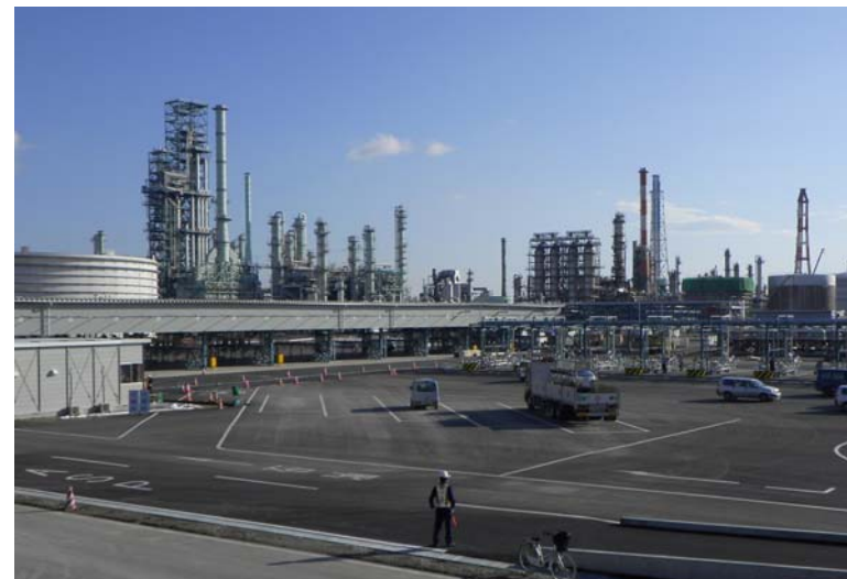
仙台製油所：建設が進む陸上出荷設備
