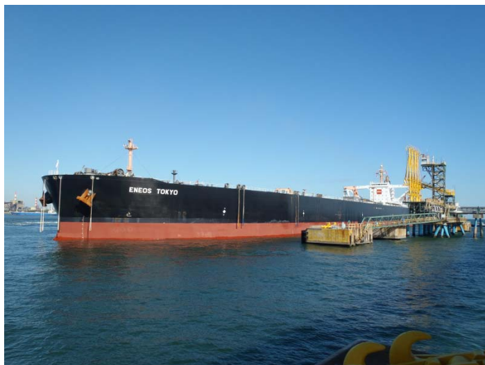
鹿島製油所：復旧した桟橋に入港した原油タンカー
