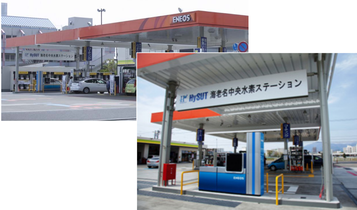
ガソリン計量機・水素充填機併設ステーション（神奈川県海老名市）
