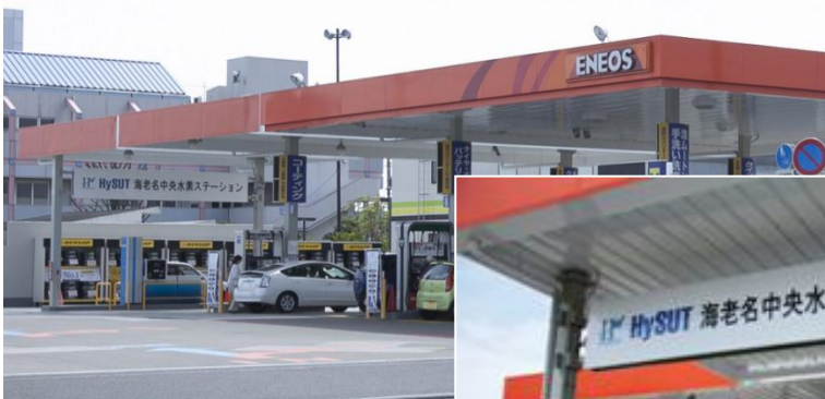
ガソリン計量機・水素充填機併設ステーション（神奈川県海老名市）
