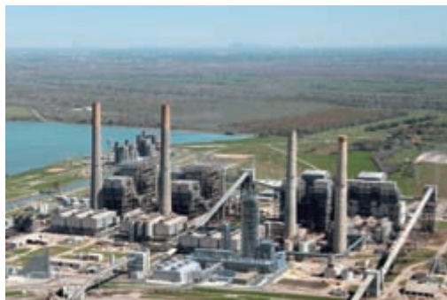
米国CO 2 -EORプロジェクト W.A. パリッシュ火力発電所
