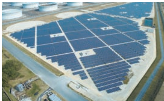
うるまメガソーラー発電所（沖縄県うるま市）
