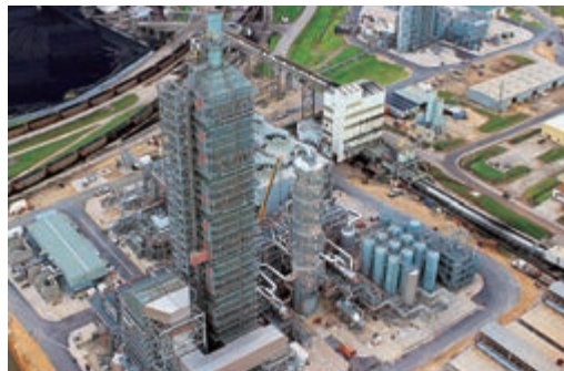
米国CO2-EORプロジェクト CO2回収プラント
