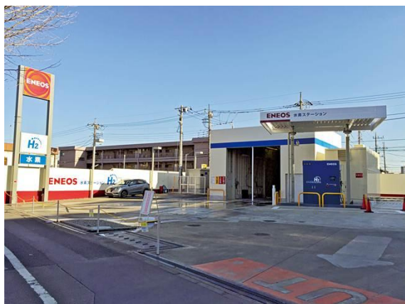
<八王子高倉水素ステーションの外観>
